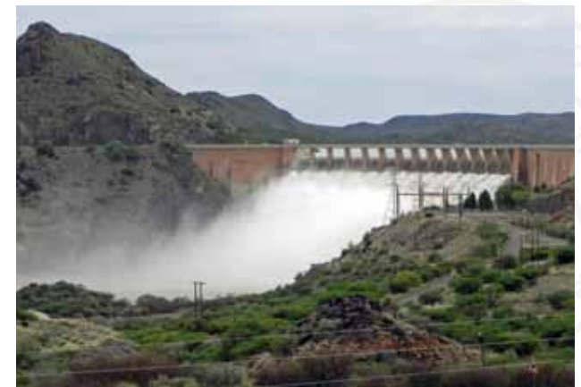
Vanderkloof Dam (© S Crerar)
